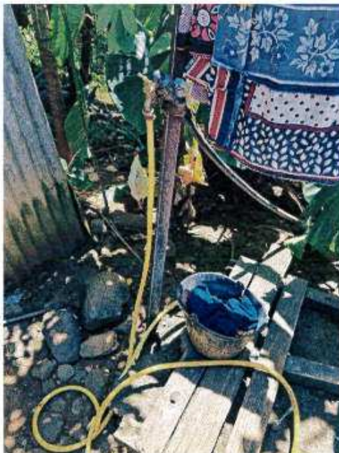
Photo n°27 : robinet d'eau à proximité du local n°34
