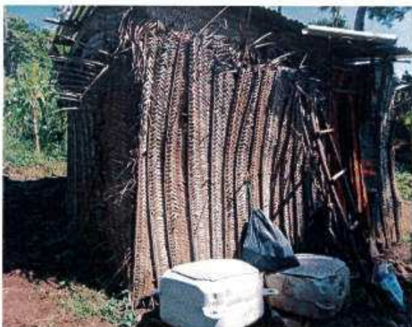
Photo n°15 : local revêtu de palme tressée
