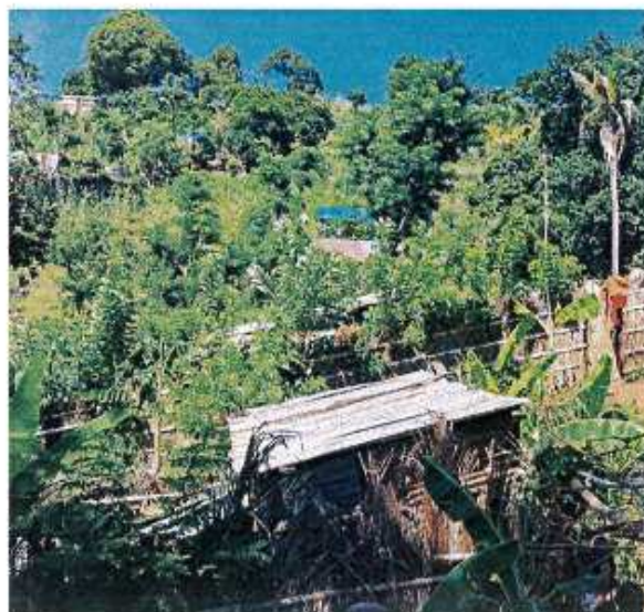
Photo n°10 : constructions diffuses à l'Ouest de la RN3
