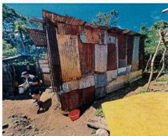
Photo n°12 : assemblage de morceaux de tôle ondulée rouillée, absence d'ouvertures donnant sur l'extérieur
