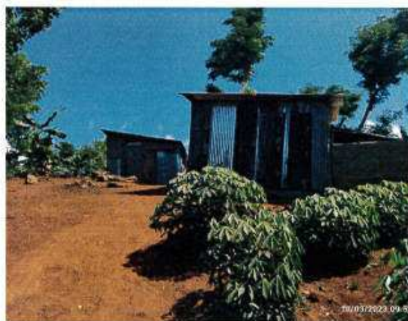
Photo n°11 : constructions précaires sur terre battue
