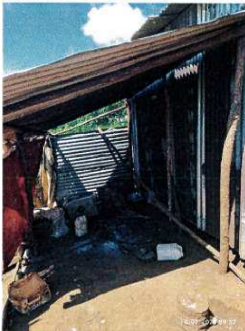
Photo n°23 : coin cuisine aménagé en extérieur, bidons usagés pour le stockage d'eau
