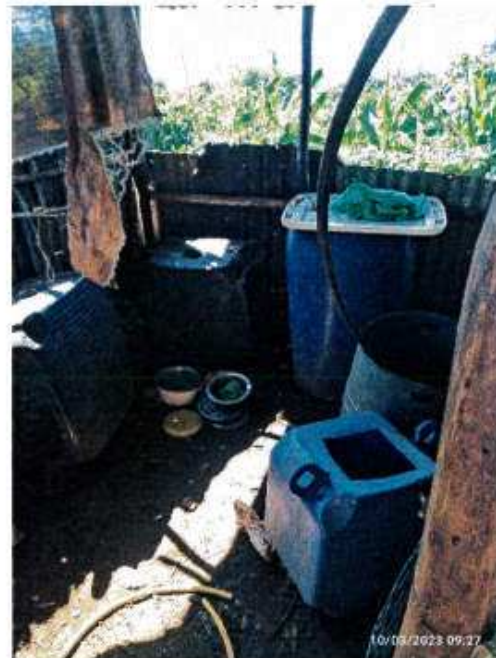
Photo n°28 : mauvaises conditions de stockage d'eau
