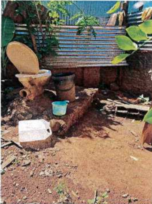
Photo 21 : équipement sanitaire rudimentaire, absence d'installation d'assainissement
