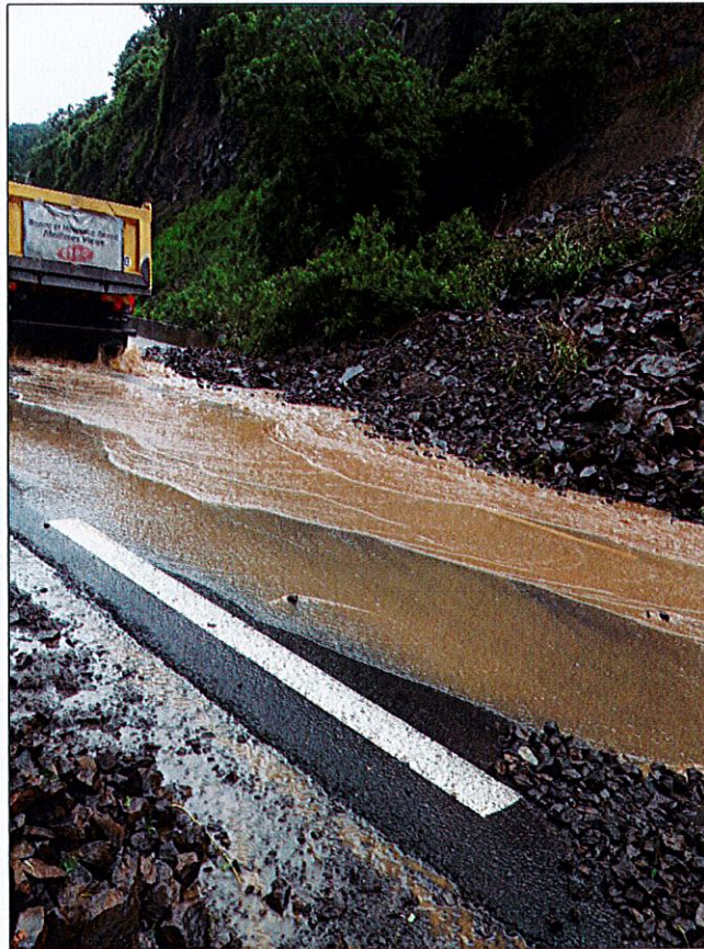
Illustration 12 - Exemples de débordement sur la RN1 au niveau de Koungou (source photographie BRGM)
