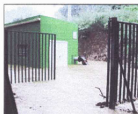
Photo 7 : Seuil de Bouyouni-Bas, le 06 février 2003 à 14h 15, station de pompage. Photo Stéphane Eienberger, Société Dubromer
