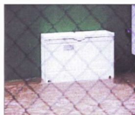
Photo 5 : Seuil de Bouyouni Bas, le 06 février 2003 à 14 h 00. Compteur EDF. Photo Stéphane Eienberger, Société Dubromer.
